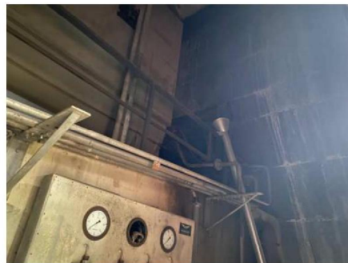
Foto 4: Beperkte ruimte en zicht en grote hoogte
