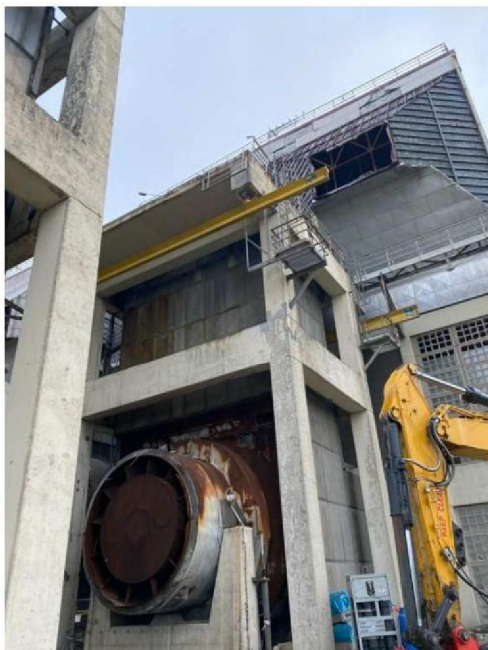
Foto 5: Beton en staalconstructie die de installatie opsluit
