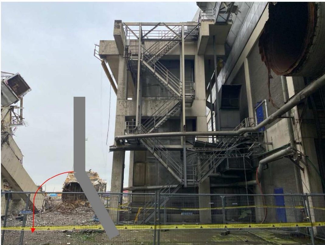
Foto 12: beoogde kantelwijze van het e-filter, schematisch weergegeven
