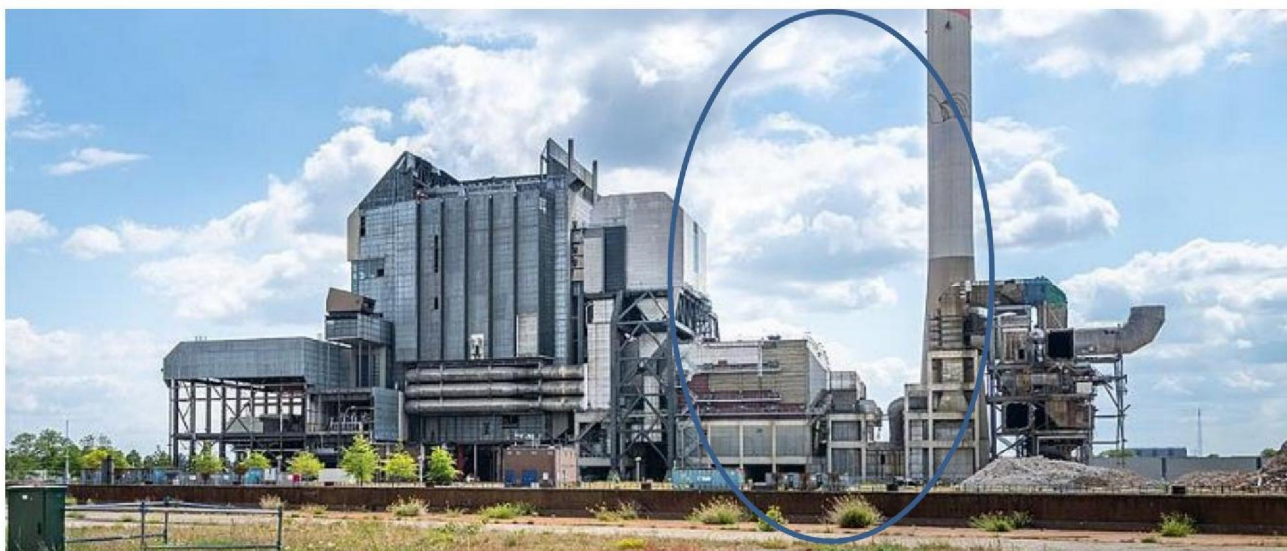
Afbeelding 1, overzicht installatie met het E-filter gebouw en de schoorsteen in blauw ovaal aangegeven.
