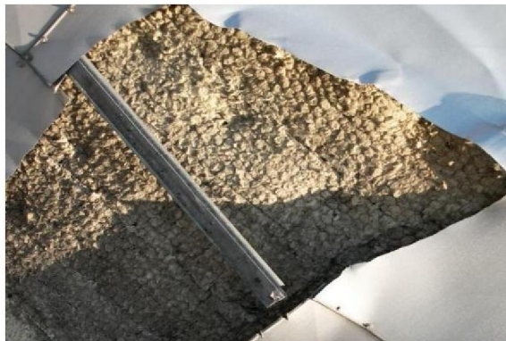
inspectie achter casing (drone)
