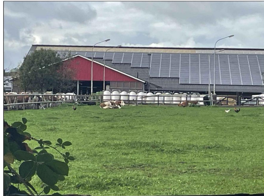
foto bestaande lichtmasten
