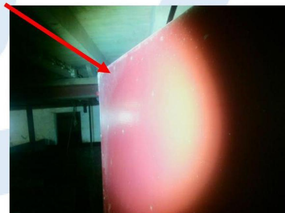
Foto 18 | Beplating op tussen deur
