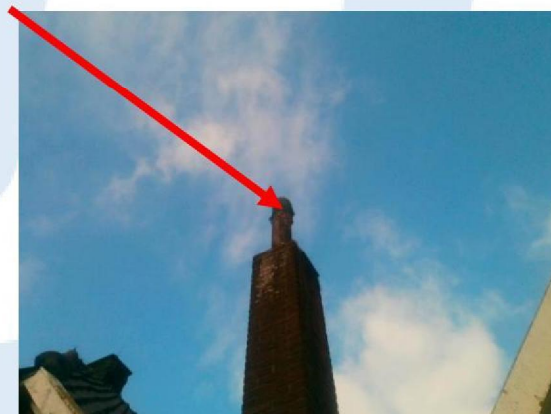
Foto 54 | Buis op schoorsteen
