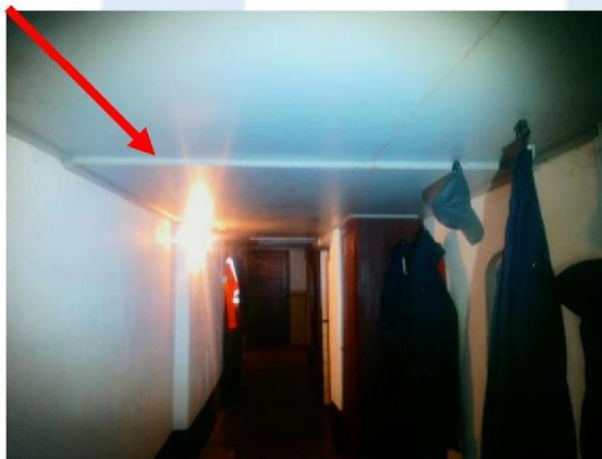
Foto 19 | Plafondbeplating gang naar deel
