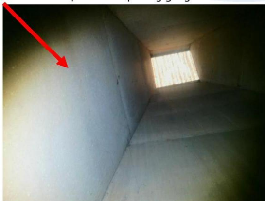
Foto 21 | Plafondbeplating gang naar deel
