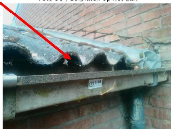
Foto 60 | Golfplaten op het dak
