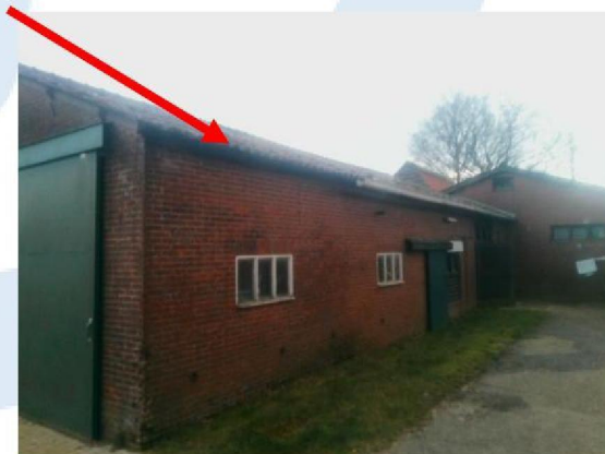
Foto 65 | Golfplaten op het dak
