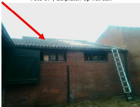
Foto 59 | Golfplaten op het dak
