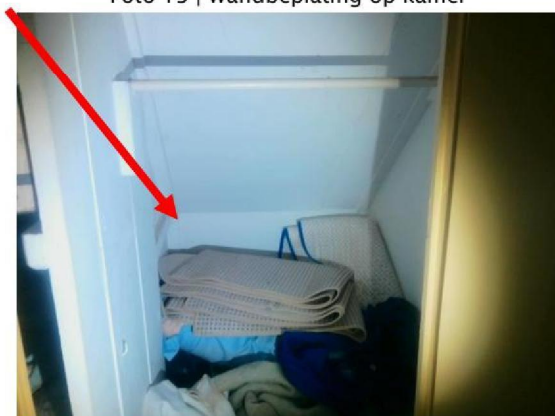
Foto 15 | Wandbeplating op kamer
