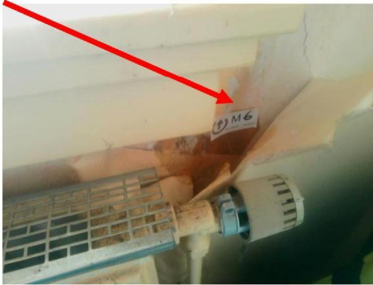
Foto 16 | Wandbeplating op kamer
