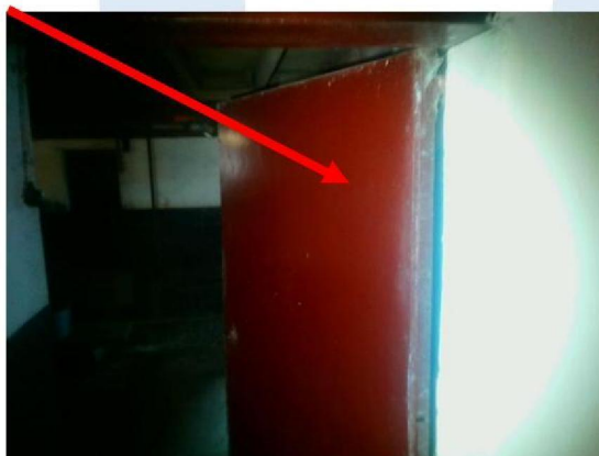
Foto 17 | Beplating op tussen deur
