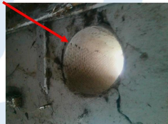
Foto 49 | Ontluchtingsbuisjes in gevel
