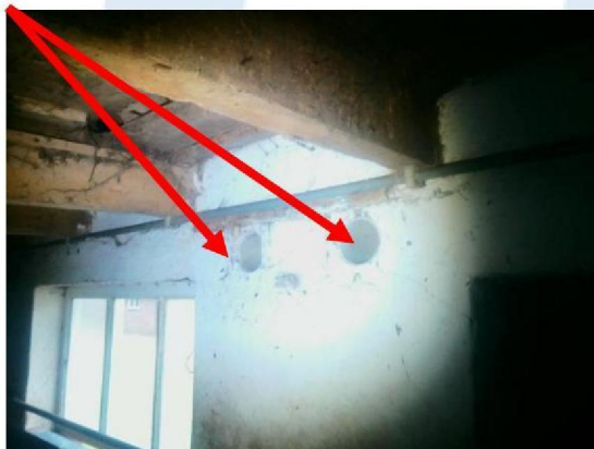
Foto 48 | Ontluchtingsbuisjes in gevel
