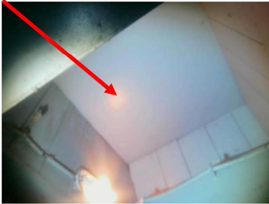
Foto 23 | Plafondbeplating gang naar deel
