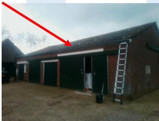
Foto 64 | Golfplaten op het dak
