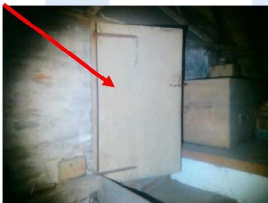
Foto 39 | Beplating op tussen deur
