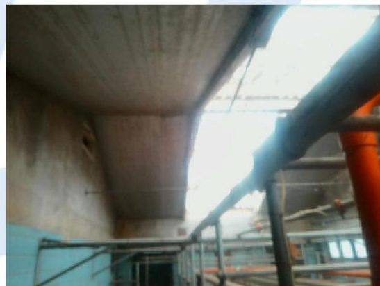
Foto 58 | Golplaten op het dak
