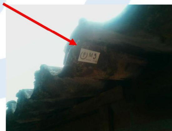
Foto 56 | Golplaten op het dak
