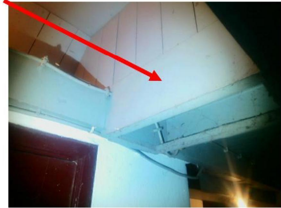
Foto 24 | Plafondbeplating gang naar deel
