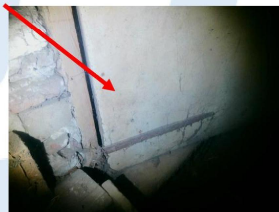
Foto 40 | Beplating op tussen deur
