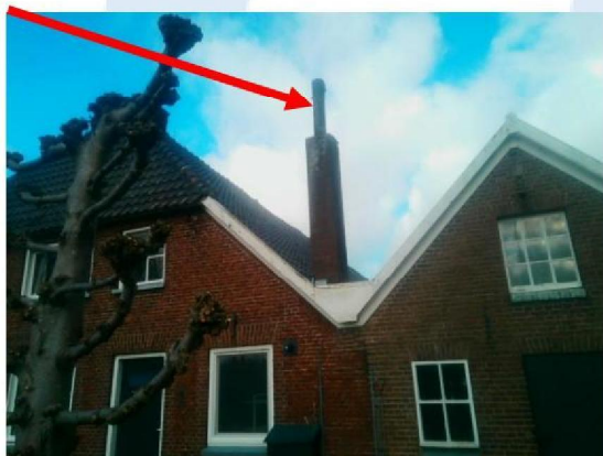
Foto 53 | Buis op schoorsteen
