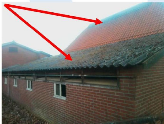
Foto 55 | Golplaten op het dak
