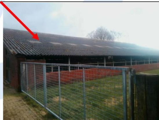
Foto 69 | Golfplaten op het dak
