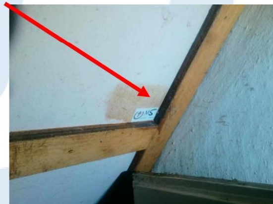
Foto 11 | Plafondbeplating kelder opgang
