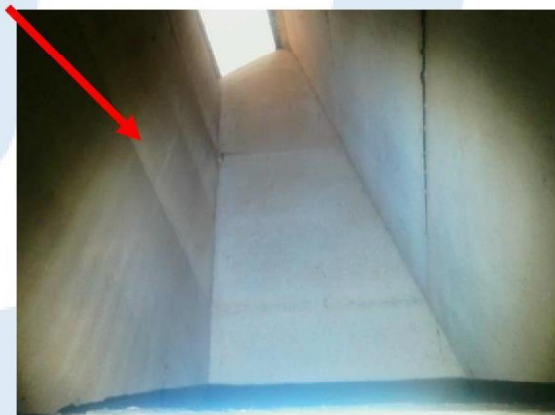
Foto 20 | Plafondbeplating gang naar deel
