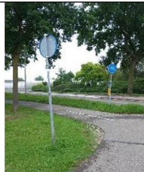
I.1.1 Onderbord OB505 aanbrengen
