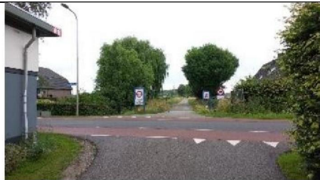
D.2 Onvoldoende oprijzicht
