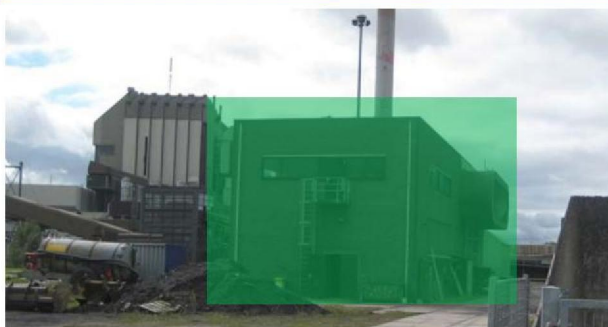
Z1L23.1: noordgevel bedieningsgebouw kolenpark
