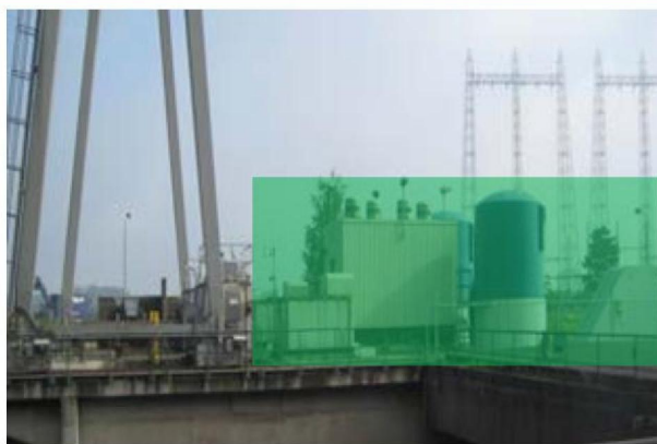
Z1L16.2: zuid zijde koelwater filtergebouw
