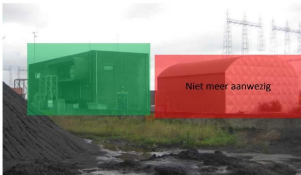
Z1L23.3: westgevel bedieningsgebouw kolenpark.
