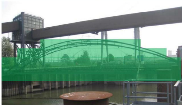
Z1L23.1: west zijde loop en leidingbrug
