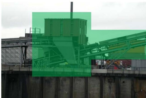
Z1L08.11: transportband, hoektoren havenzijde
