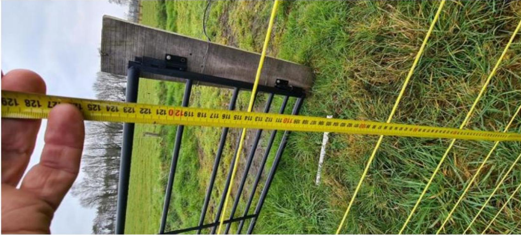
Hoogte tussen de paaltjes op 114 cm hoogte. - 12-03-2024 19:09
