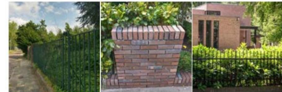
Bestaand hekwerk aan buitenrand, aangevuld met gemetselde poeren i.c.m. haag
