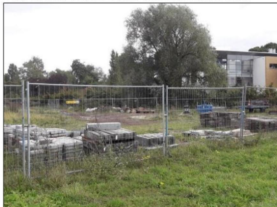
Foto 9: Deel terrein in voor bouwwerkzaamheden
