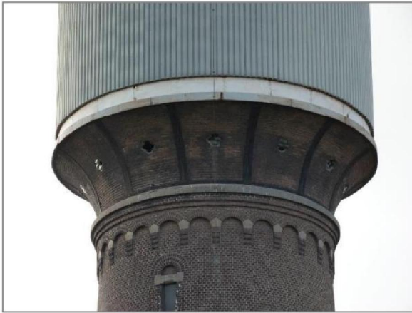
Afbeelding 1.3 | Ramen bovenzijde watertoren.
