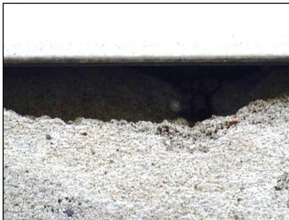
Figuur 2. Eén van de gaten onder de dakstrip.
