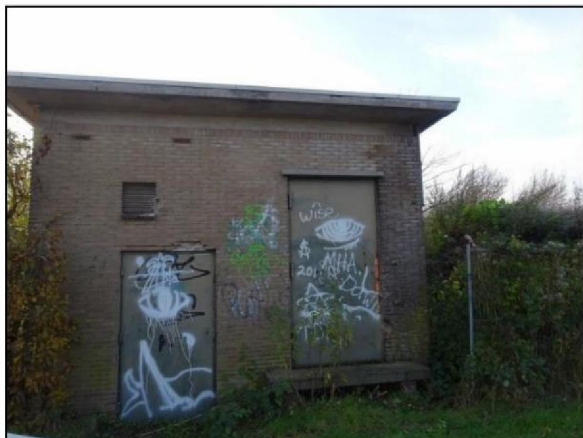
Figuur 1. Transformatorhuisje in het plangebied De Drijen.
