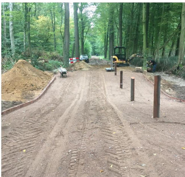
Aanleg van doorrijdbare plek
