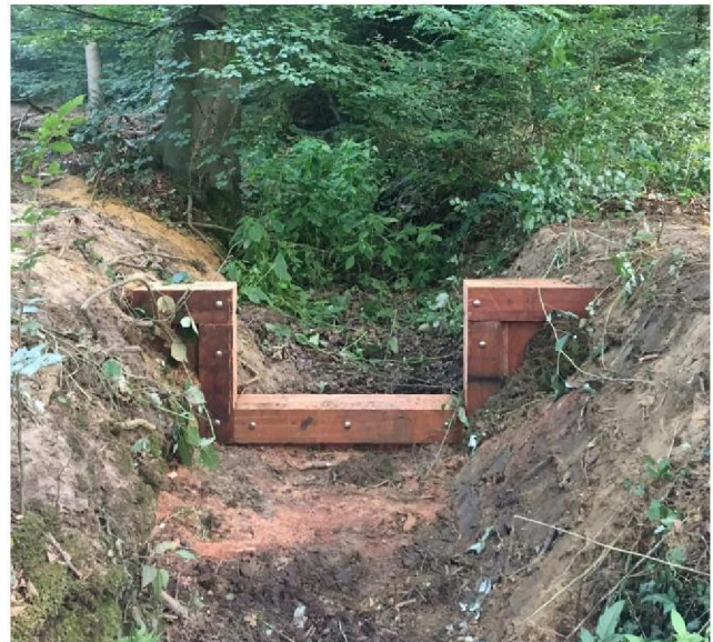
Aanleg van schotbalkstuw
