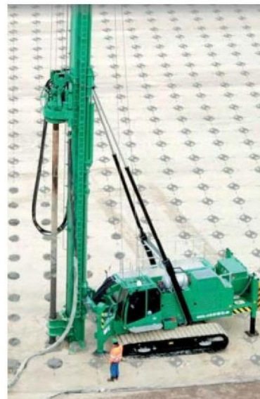
Figuur 2 Impressie van veld met betonzuilen
