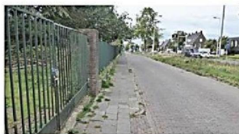
Hekwerk langs de Ritzema Bosweg
