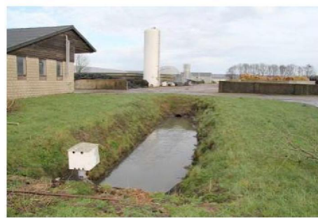
Figuur 4. Westzijde terrein met afwatering.
