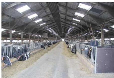
Figuur 3. Te slopen rundveestall 1.
