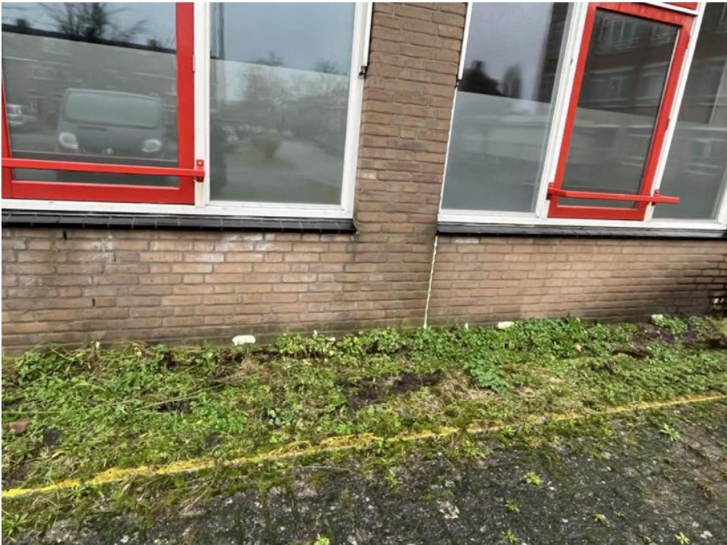
Pur begane grond -13 - 19-12-2023 15:11
