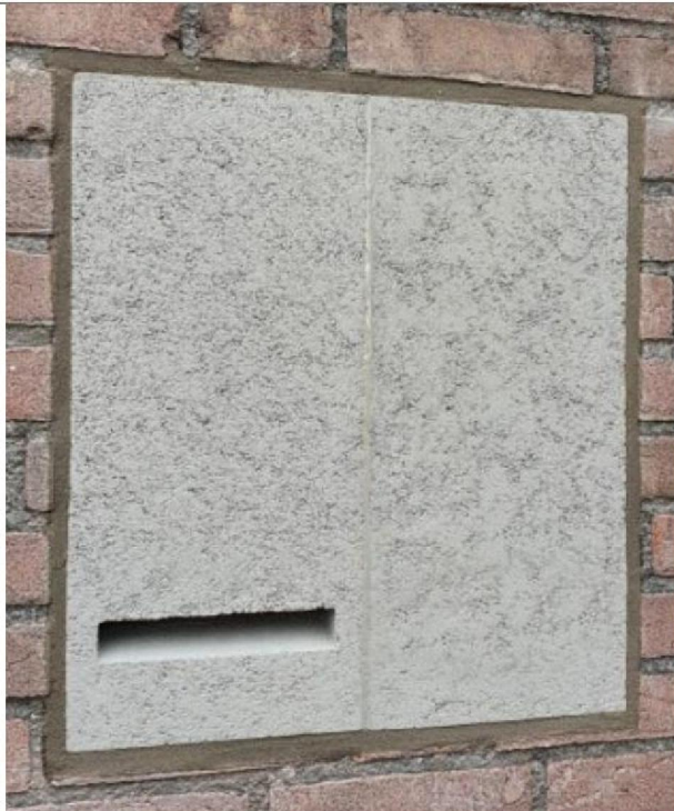
Ingemetselde vleermuiskasten bestaande uit een VMPM2 en een VMPM2u.
