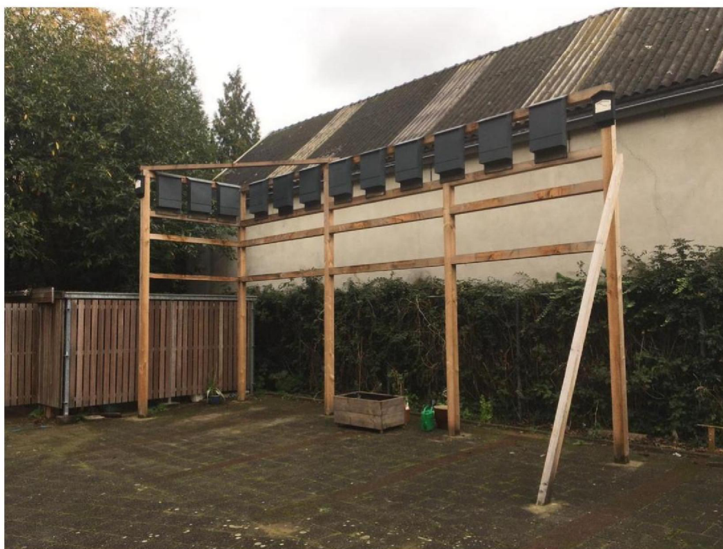
Foto 5 Tijdelijke vleermuiskasten aan stellage gelegen tegen monumentale schuur
