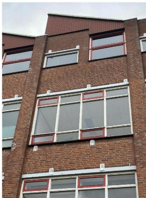
Foto 2 Voorbeelden van faunawering: te zien zijn exclusion flaps die voor alle open stootvoegen zijn aangebracht.
