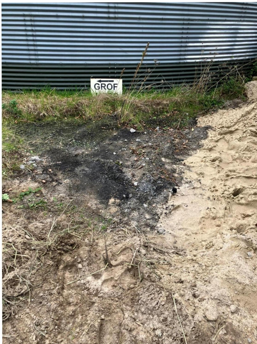
Foto 6: ongebonden en/of niet afgedekte FORZ (bestaande uit bodemas en/of sorteerzeefzand) aan zuidzijde proefveld
