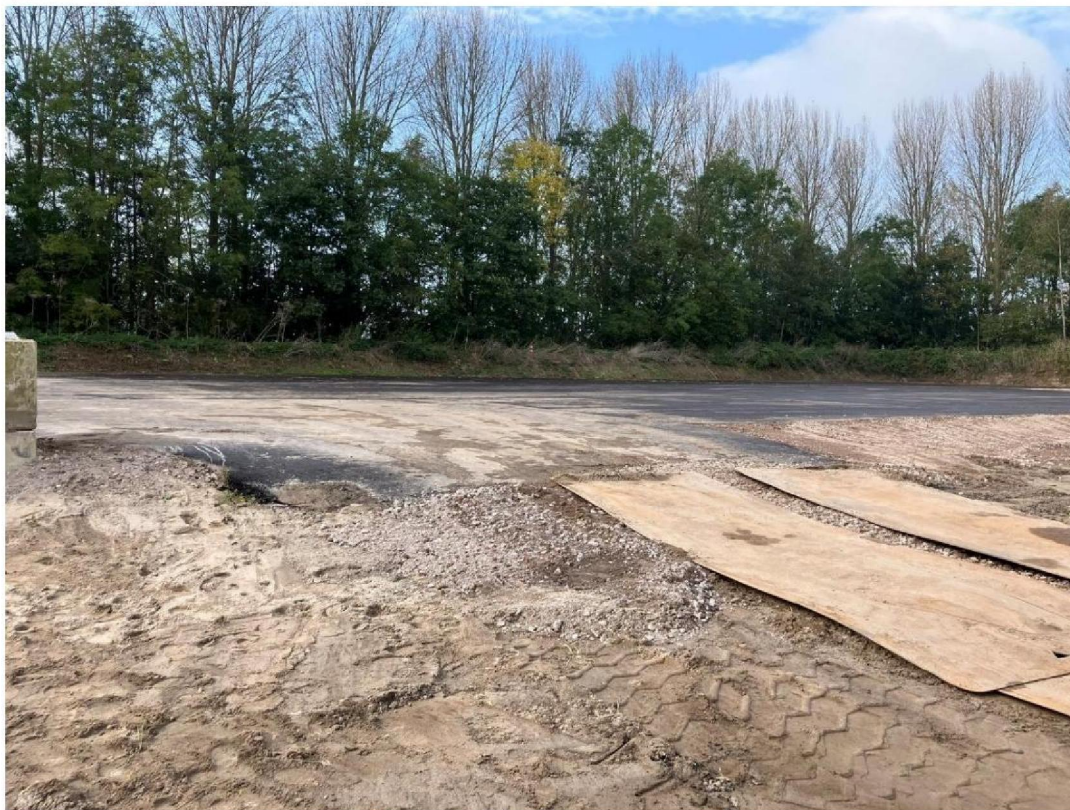
Foto 10: oprit (oostzijde) afdoende afgedekt met menggranulaat en/of zand
