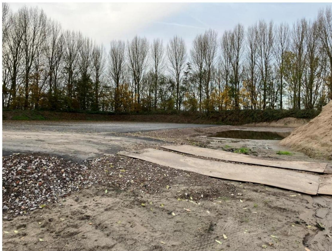
Foto 12: oprit (oostzijde) afdoende afgedekt met menggranulaat en/of zand
