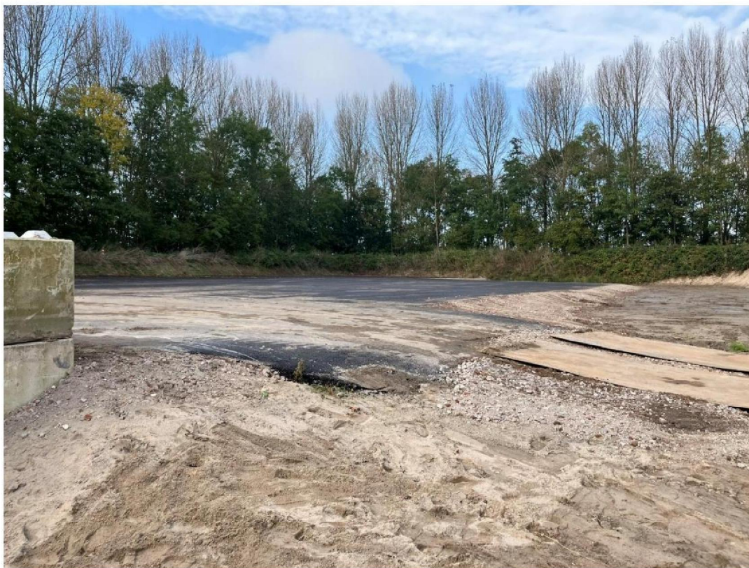
Foto 11: oprit (oostzijde) afdoende afgedekt met menggranulaat en/of zand
