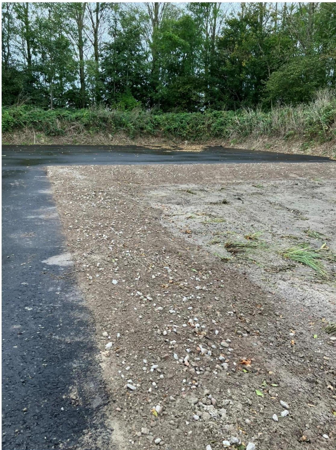
Foto 3: taluds proefveld immobilisaat afgedekt met menggranulaat
