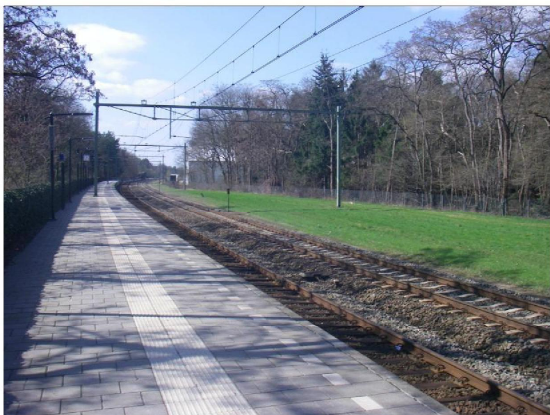
Figuur b2.2 Foto emplacement vanaf perron 1 (noordwestelijke richting)
