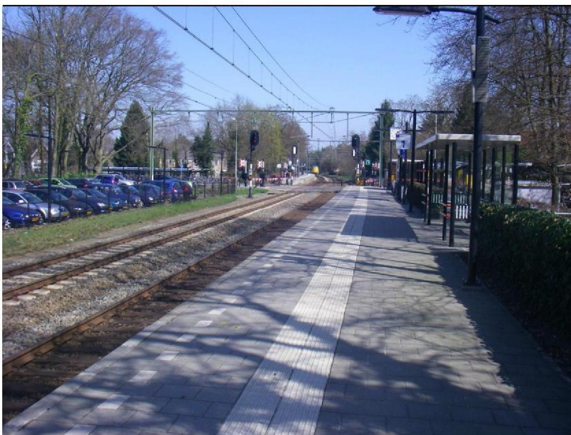
Figuur b1.4 Foto NS-station vanaf perron 1 (noordoostelijke richting) (2)
