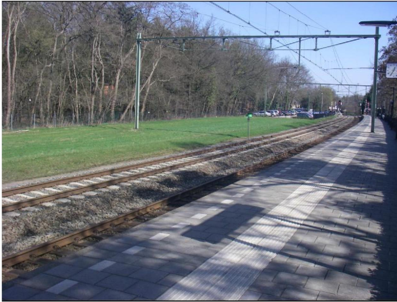
Figuur b1.3 Foto NS-station vanaf perron 1 (noordoostelijke richting) (1)
