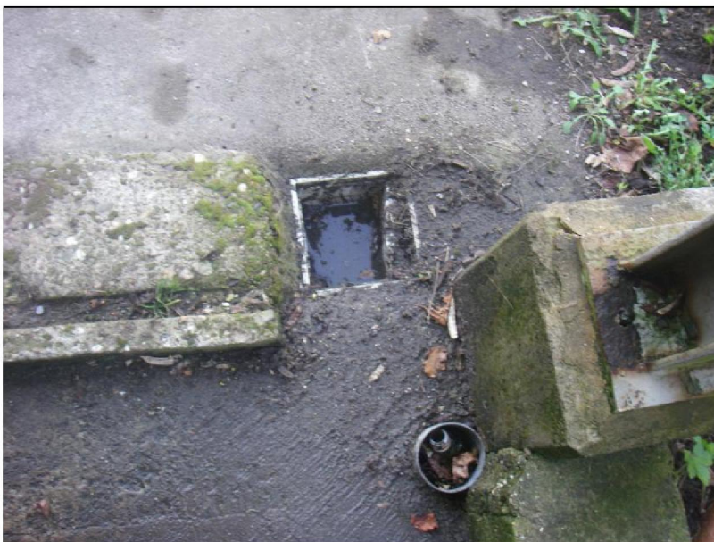
Figuur b1.4 Detailfoto lozingsput op terrein van voormalige MER ICT Groep
