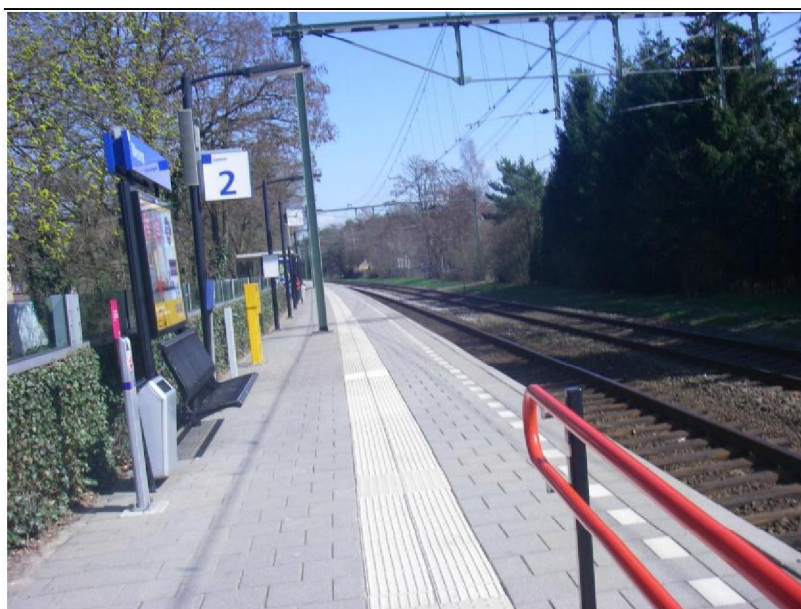
Figuur b2.3 Foto emplacement vanaf perron 2 (zuidoostelijke richting)
