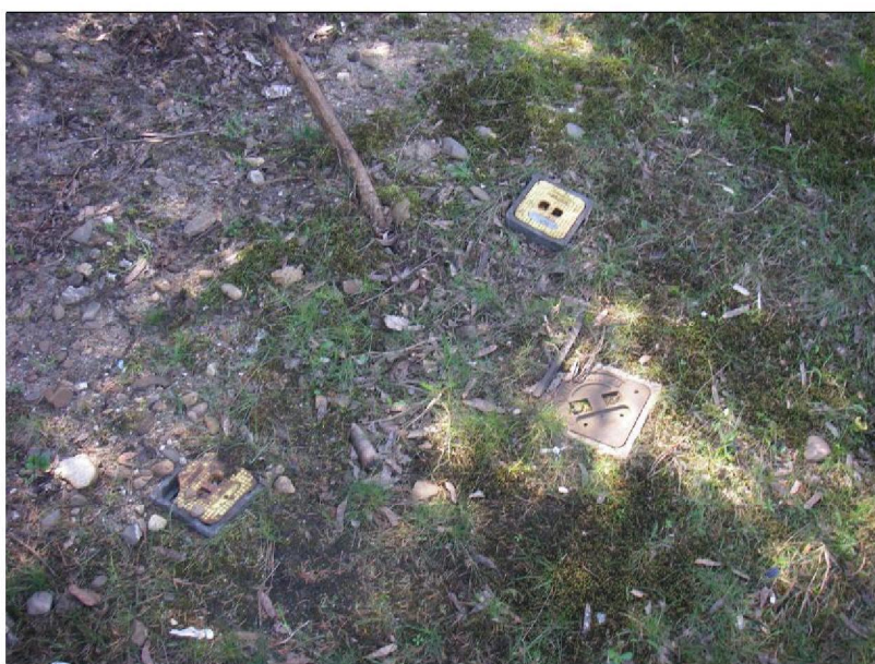
Figuur b1.2 Foto van enkele peilbuizen in zand/grasstrook tegenover perron 2
