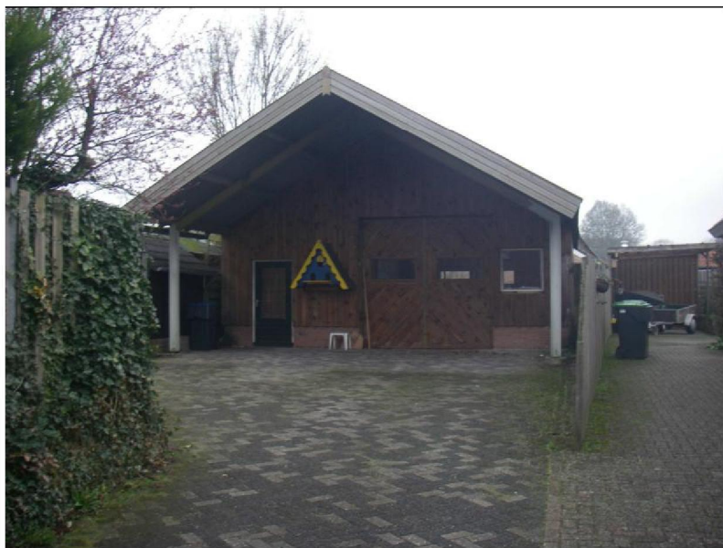
Figuur b2.2 Schuur aan de achterkant van de woning
