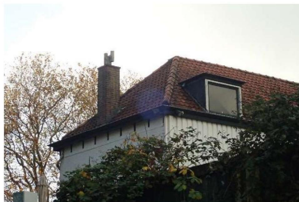
Figuur 4.3: achterkant van het woonhuis met schoorsteen en dakkapel
