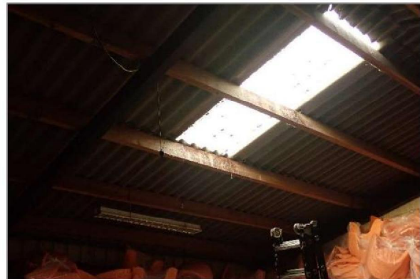
Afbeelding 1.10 | Binnenkant van de tweede loods
