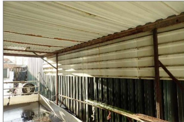
Afbeelding 1.8 | Binnenkant van de tweede loods
