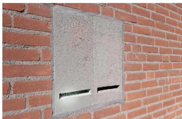
Ingemetselde VMPM3's met twee invliegopeningen
