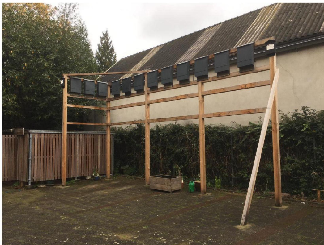
Foto 4 Tijdelijke vleermuiskasten aan stellage gelegen tegen monumentale schuur
