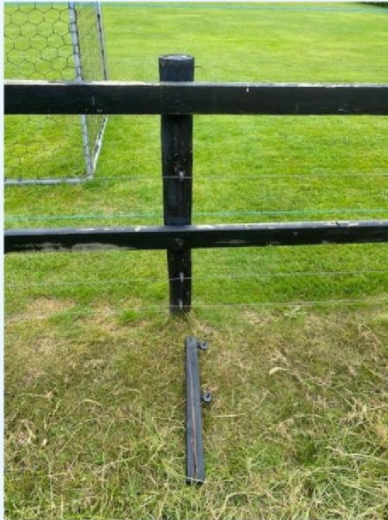
Uitsprongplek met afgebroken lat.jpg
