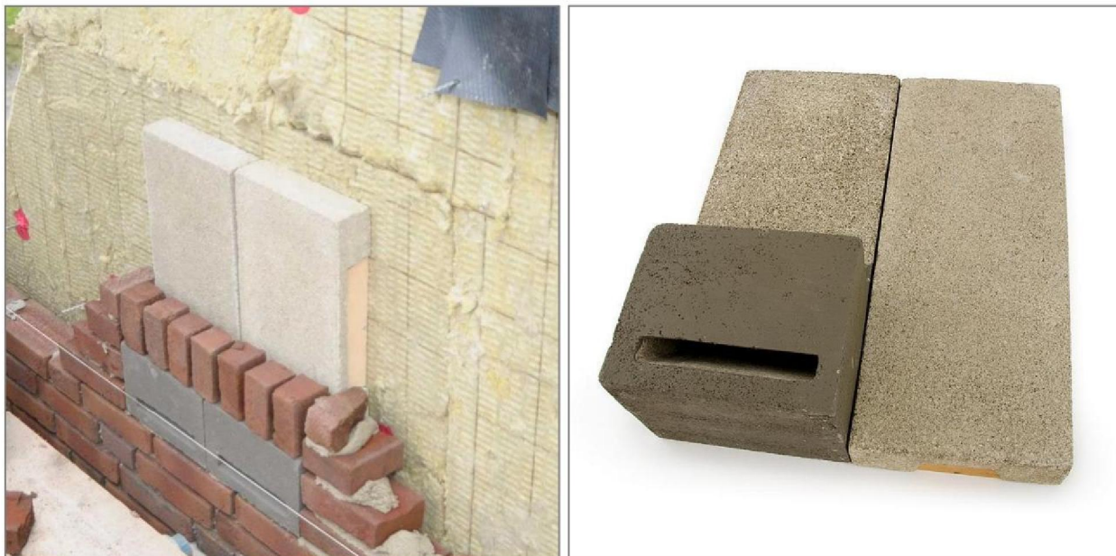
Figuur 6 | IB VL 01 gekoppeld ingemetseld.
