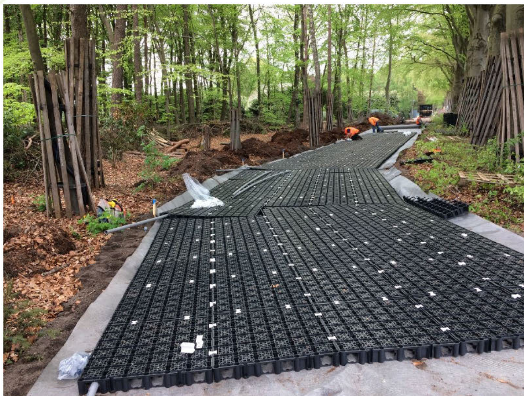
Afbeelding 16: Toepassing van Permavoidkratten als fundering van een betonnen fietspad in een bos;
