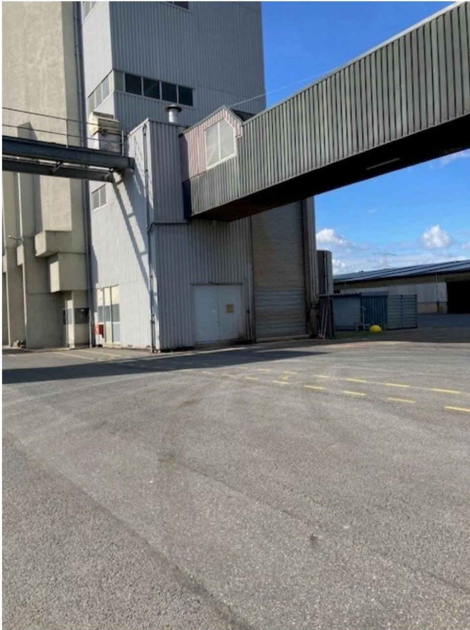
Aanvoer grondstoffen stortput oost productiegebouw
