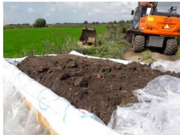
Foto 8: Ontgraven materiaal in een container met asbest zak geladen.
