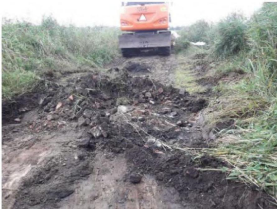
Foto 7: Beeld van samenstelling ontgraven puinpad.
