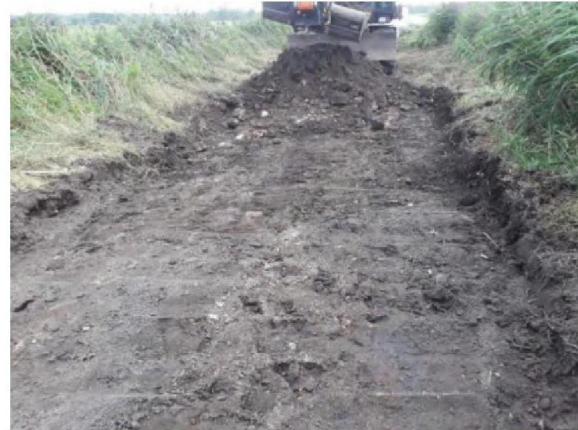
Foto 6: Puinpad blijkt met 4 meter duidelijk breder dan verwacht/aangegeven in het onderzoek vooraf.
