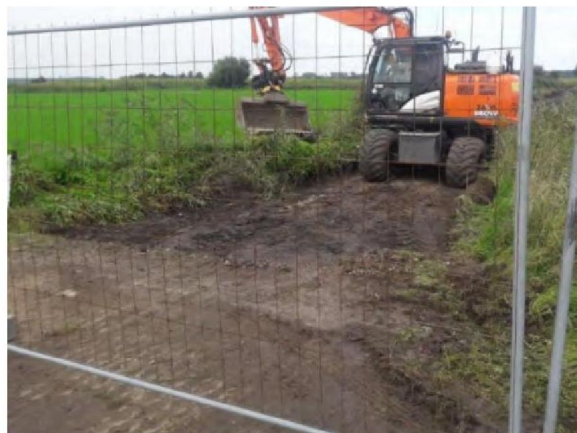
Foto 12: Ontgraving afgerond met aansluiting op de openbare weg (Achterwegje).
