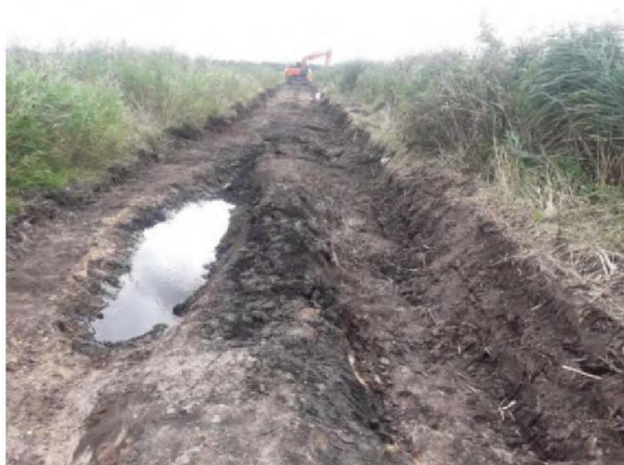
Foto 11: Einde ontgraving zuidzijde met plaatselijk diepe ontgraven rijsporen.
