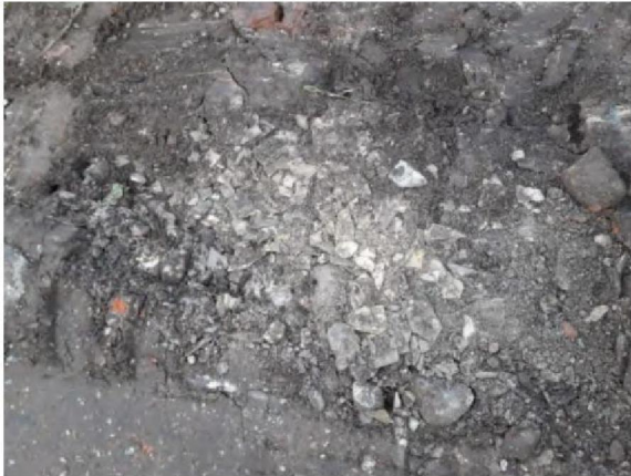
Foto 5: Plaatselijk zijn nestjes asbesthoudend plaatmateriaal aangetroffen (wat het tijdens het onderzoek aangetroffen hoge gehalte verklaart).
