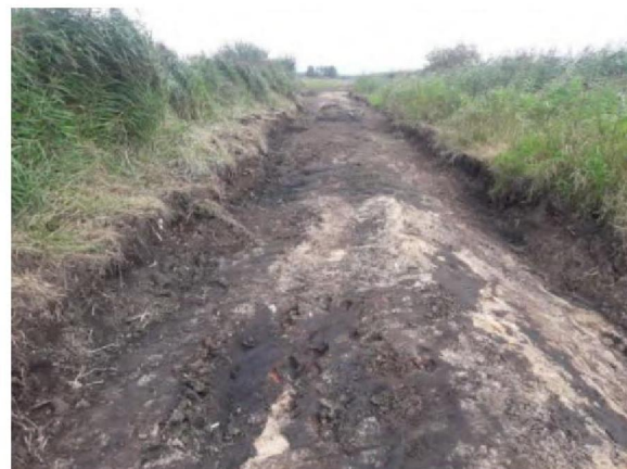
Foto 10: Einde ontgraving noordzijde.
