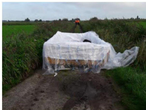
Foto 2: De verontreinigde puinlaag wordt geladen in 10 m 3 containers in asbestzakken. Nadat de zakken dicht zijn gemaakt worden 2 containers per bon = per vrachtwagen afgevoerd.
