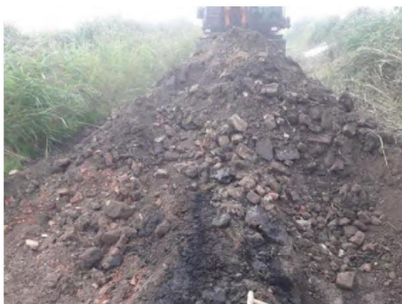
Foto 3: Tussendepot ontgraven puinverharding voor opladen in container.
